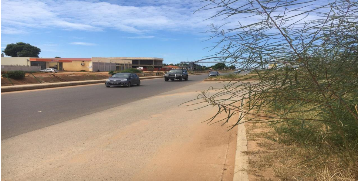
Figure 1, ilustra cerca destruida pelos acidentes
